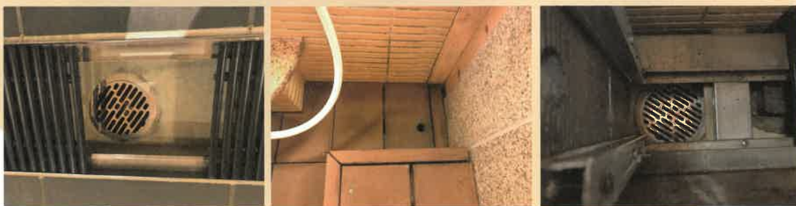
浴室内排水溝
